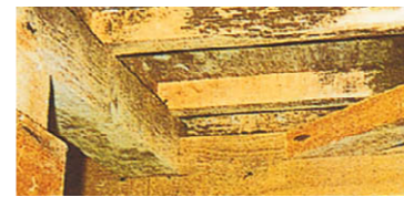
A 床下換気扇を設置していない床下
