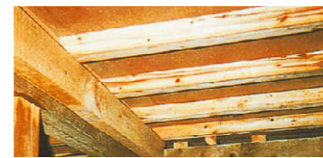
B 床下換気扇を設置している床下
